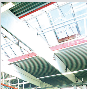
▲ Instalace do sedlového světlíku
